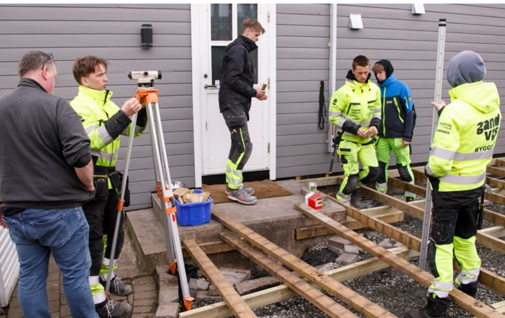
Elevene motiveres av å få bygge ekte prosjekt. Her skal de legge en 77 kvadratmeter stor terrasse i to nivå. Kjell Åge Lillehavn instruerer Terje Solbjørg under oppmåling. Eivind Ravndal Kyllingstad (t.v.), Sebastian Skjæveland Haga, Jevgeni Makarov og Kristoffer Aspøy Gjesteland er også med.
