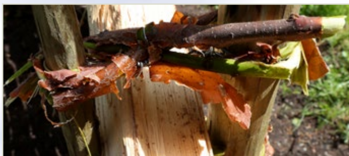
Ferske vidjer surret rundt stolpene. Ståltråden er brukt for at det skal bli enda sterkere.
