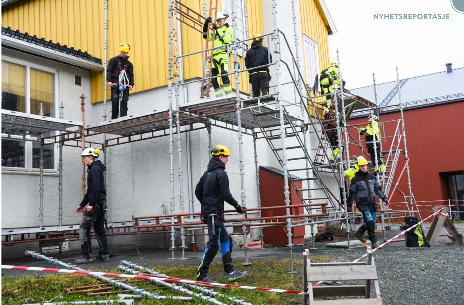
Elevene har stillaskurs, og det er mange deler som skal på plass.
