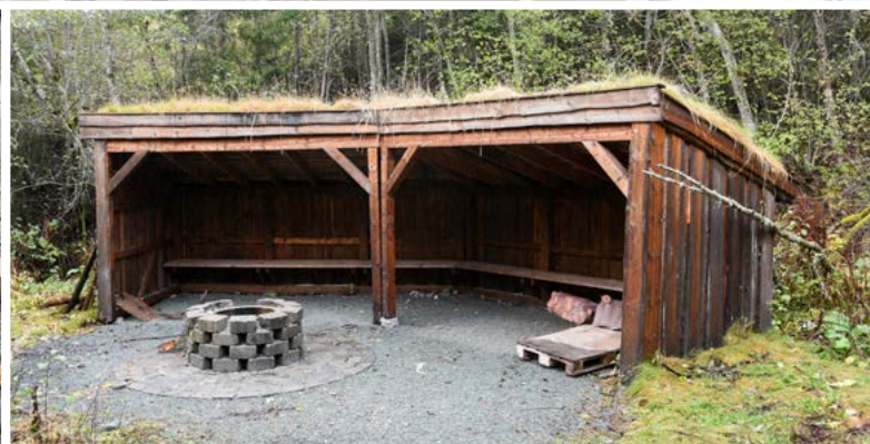
Reisverket på denne gapahuken er gjenbruk fra det gamle fjøset, og bordkledningen har elevene laget på egen sag.
