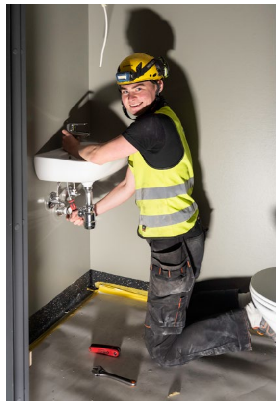
Som rørlegger må du være bevegelig. Daniel Bergmann fuger rundt et nytt toalett, og det er ikke store plassen å boltre seg på.
