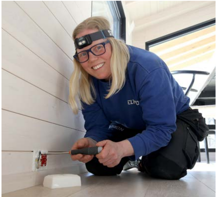
Mari Skogstad Østgård monterer stikkontakt på veggen i en hytte – som hjelpearbeider i elektrikerfaget.
