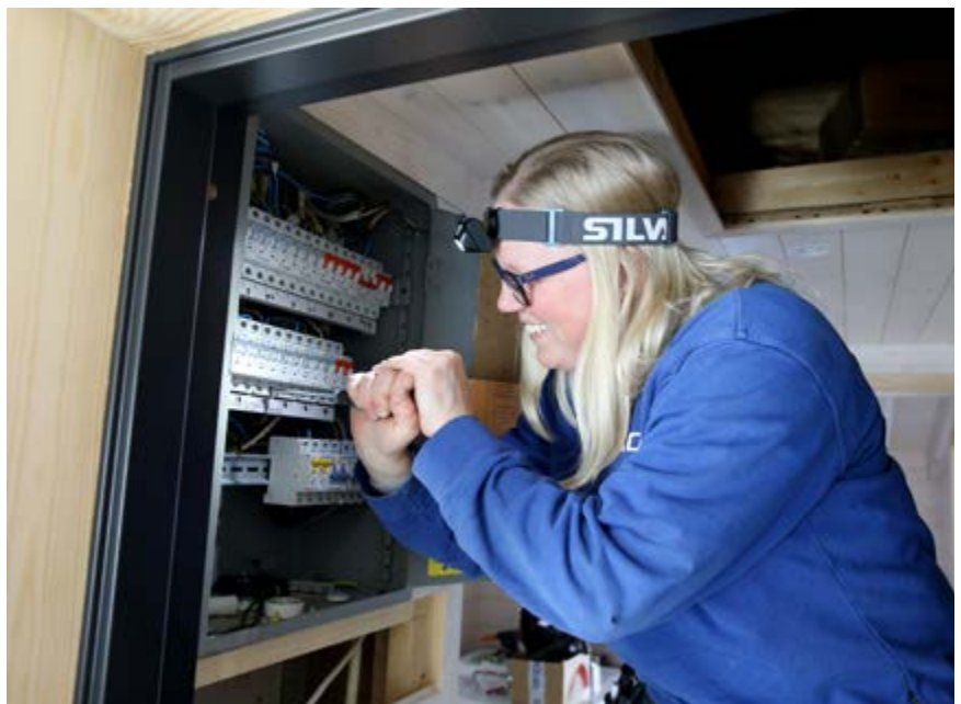
Mari Skogstad Østgård skruer fast en skrue i sikringsskapet.
