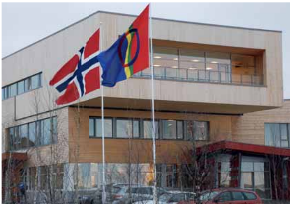
Diehtosiida, vitensenteret i Kautokeino, som stod nytt høsten 2009. Bygget huser Sámi allaskuvla (Samisk høyskole), og også, i tredje etasje, Samediggi – Sametinget.
